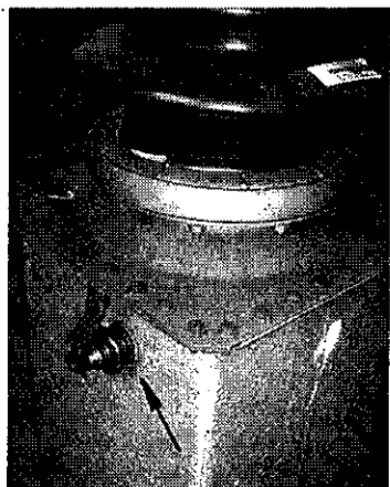
Рис. 10.9. Тестовый вывод маслонаполненного трансформатора тока класса 160 кВ служащий для проверки состояния высоковольтной изоляции
